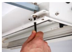
Изменение высоты установки одним винтом
