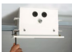
Отрегулируйте рычаги для закрепления в потолке
