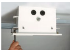
Отрегулируйте рычаги для закрепления в потолке
